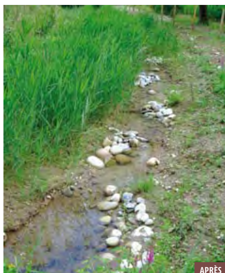
Diversification de l'écoulement du nant au moyen d'épis en boulets.
