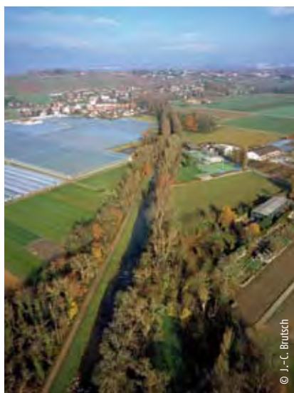
Vue aérienne de l'Aire canalisée.
