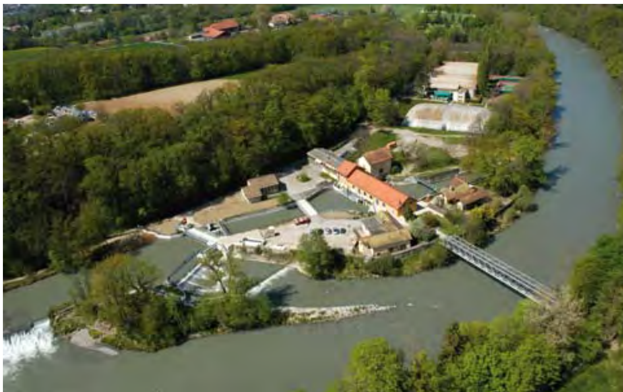
Barrage et usine hydroélectrique de Vessy. Les seuils infranchissables ainsi que l'échelle à poissons se trouvent au premier plan.
