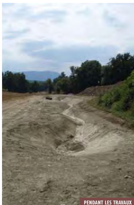
PENDANT LES TRAVAUX
