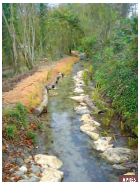
Mise en place de sous-berges pour les poissons et plantations aquatiques.
