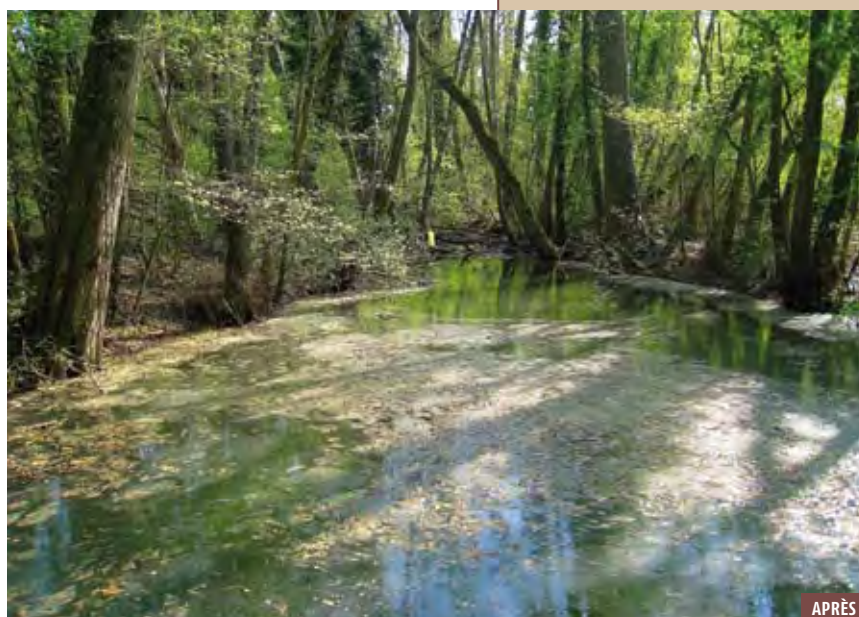
Création d'une surverse à l'étang des Anges.
