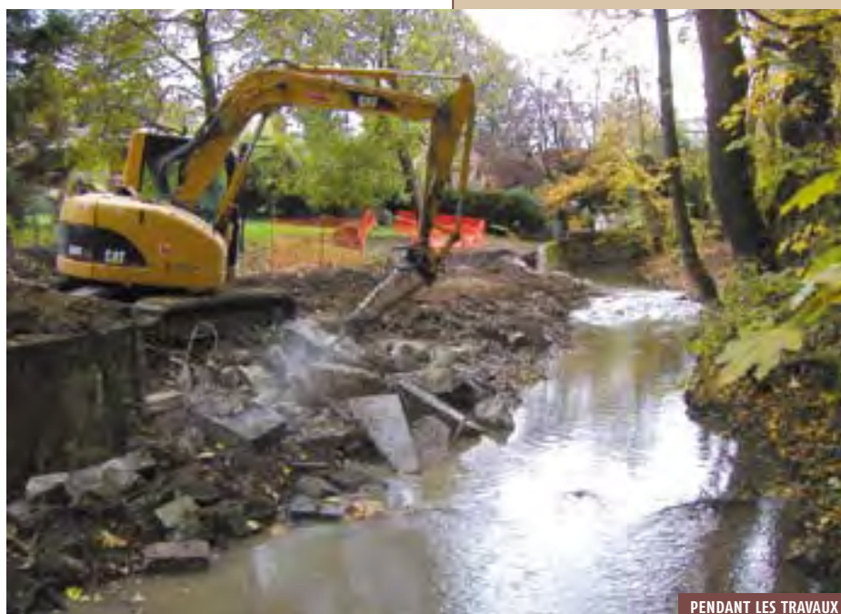
PENDANT LES TRAVAUX
