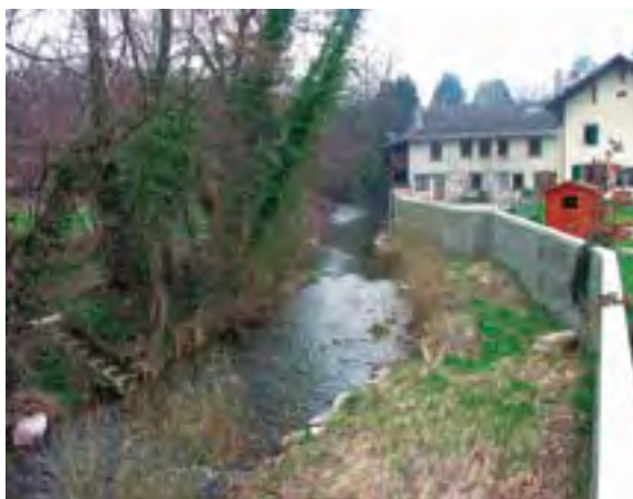
Là où l'espace faisait défaut, un mur a été construit pour protéger les habitations du village d'Hermance.
