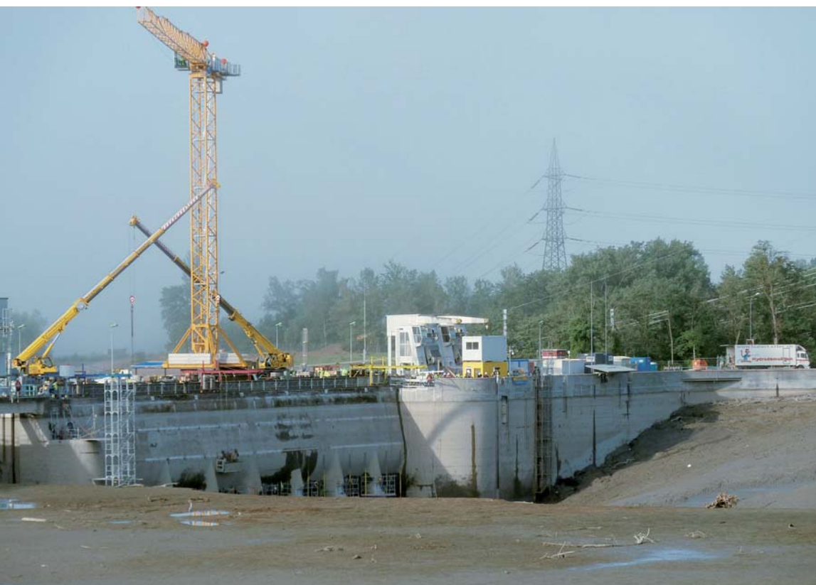
Le lac de Verbois vidangé, avec le chantier du changement des grilles de protection des turbines du barrage. 14 juin 2012.
