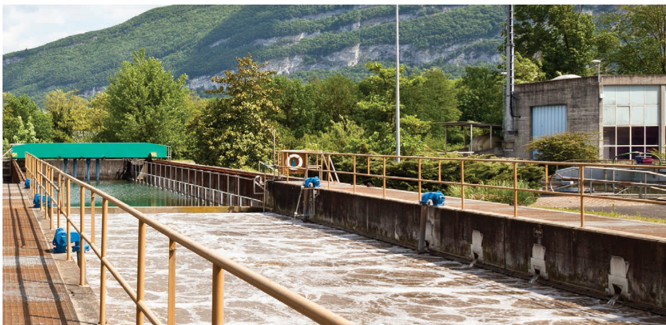
Bassins extérieurs de la STEP de Villette
