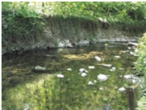
Erosion en aval du pont de Drize.
