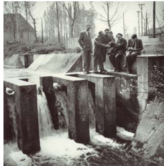
Canalisation de l'Hermance à Veigy (1960).
