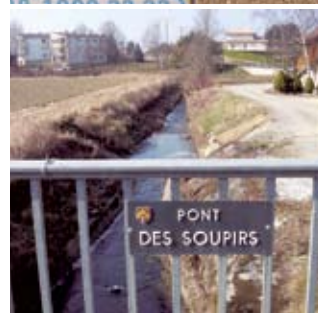
Canalisation de l'Hermance et urbanisation à Veigy.
