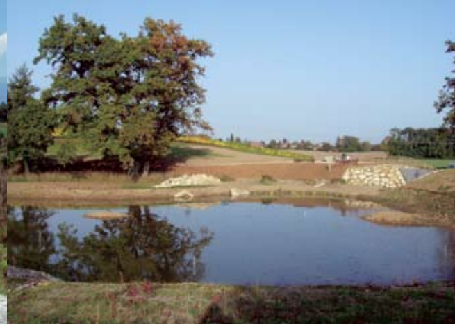
Bassin de rétention du Marquet
