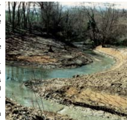
Stabilisation des berges du Gobé
