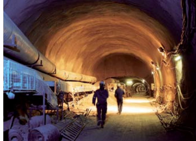
Construction du LHC
