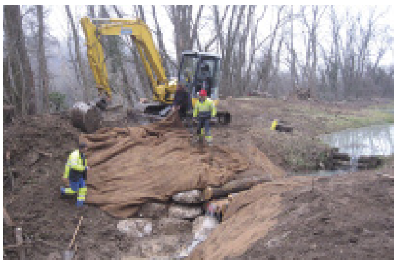
Travaux de renaturation
