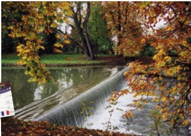
Seuil infranchissable pour les poissons : des travaux sont prévus dans le cadre du contrat de rivière.
