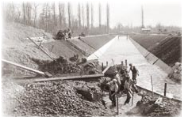
Chantier de canalisation de l'Aire (1932).
