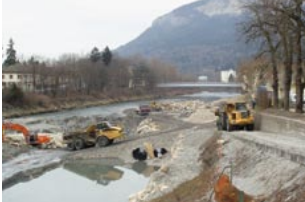
Réalisation d'un contre-seuil à Bonneville
