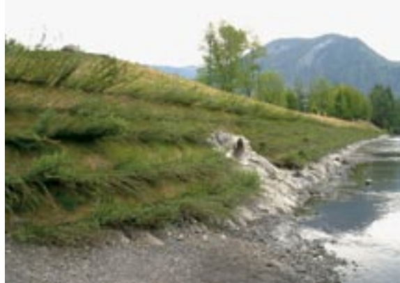
Protection des berges de Cluses.
