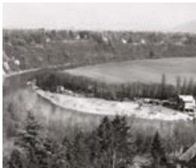
Extraction de gravier à Vessy.
