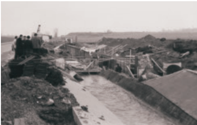
Le Nant d'Avril est enterré sous la piste cyclable de la route du Mandement (1966).
