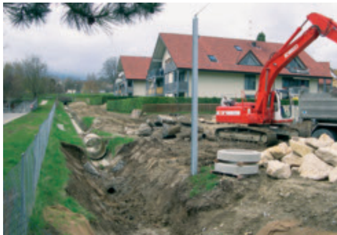
Travaux de renaturation du Pré-Gentil (2006).
