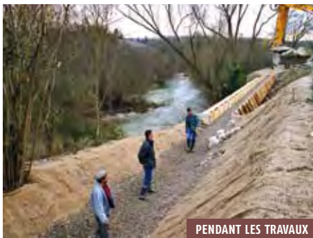
PENDANT LES TRAVAUX
