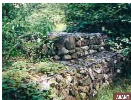
Protection de berge en gabions (galets entourés de filoches).
