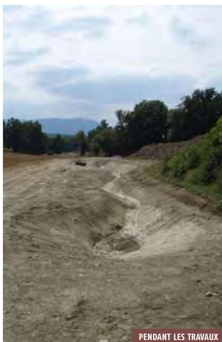
PENDANT LES TRAVAUX
