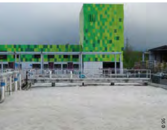
Nouvelle station d'épuration de Bois-de-Bay.
