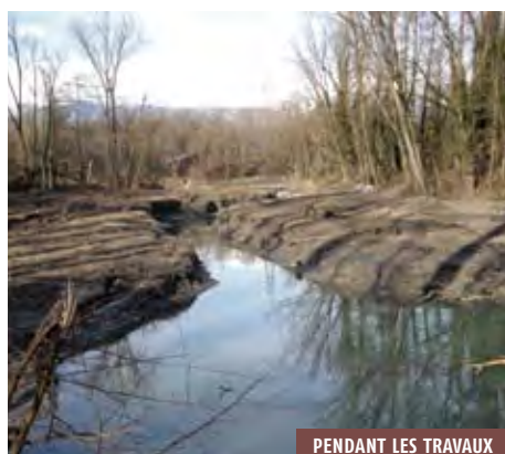
PENDANT LES TRAVAUX
