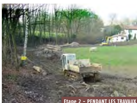
Etape 2 - PENDANT LES TRAVAUX
