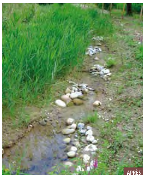
APRÈS Diversification de l'écoulement du nant au moyen d'épis en boulets.
